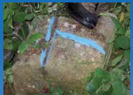
Système intéressant de repérage des drains
